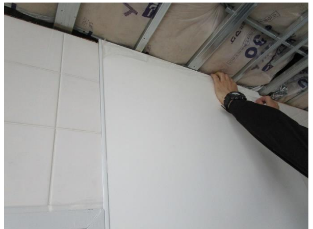
■ ON タイル工法で既存タイルの上から直接施工した事例
